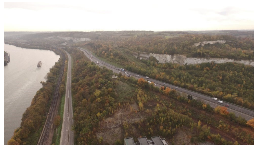
Seine, Chemin de fer et Route entre Mantes-la-Jolie et Mézières-sur-Seine - CU
