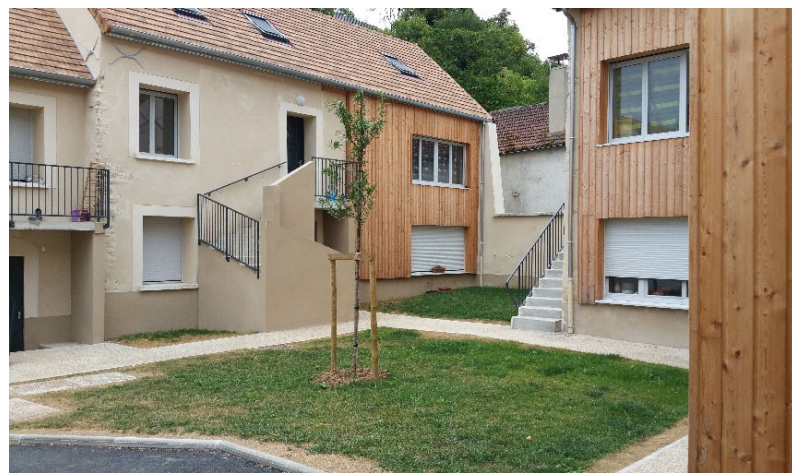
Corps de ferme réhabilité en logements à Guerville
