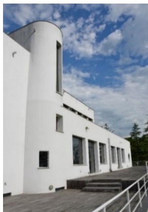
Villa Poiret à Mézy-sur-Seine – Rob Mallet Stevens, Architecte
