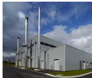
Chaufferie Bois – Mantes-la-Jolie
