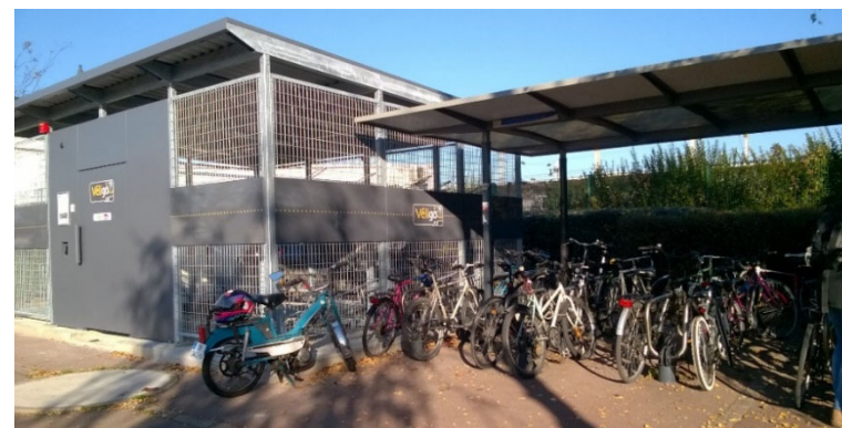
Stationnement à vélo sécurisé et stationnement à vélo abrité en gare de Vernouillet-Verneuil
