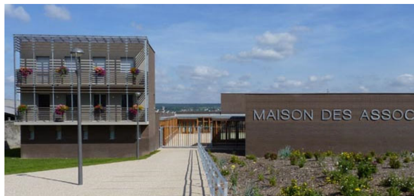
Maison des associations – Aubergenville – Nordström et Bertin architectes
