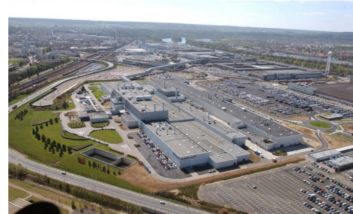
Vue aérienne – PSA
