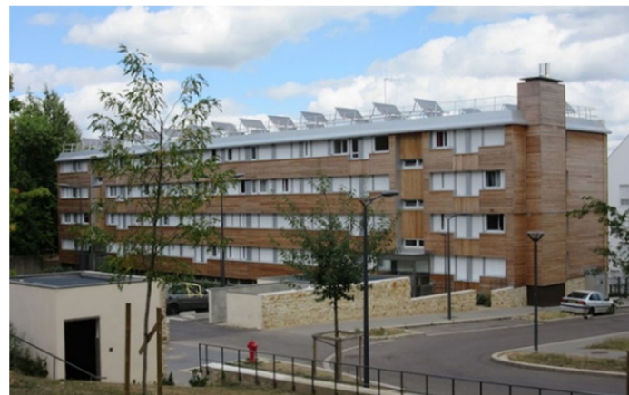
Bâtiment réhabilité dans la ZAC du Clos des Bois à Ecquevilly © Ekopolis
