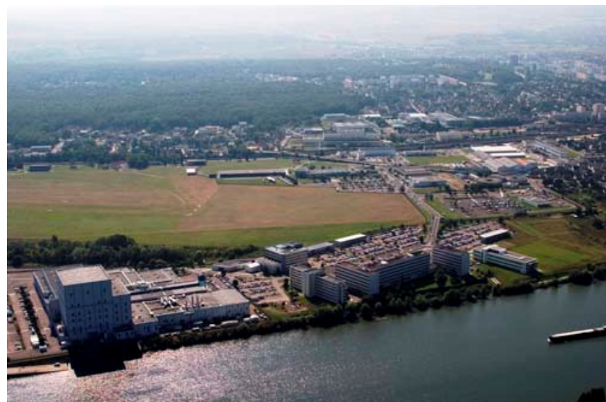
Vue aérienne Airbus Defense and Space – Les Mureaux
