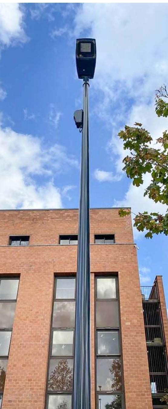
Cette rénovation consiste essentiellement au remplacement progressif des lanternes à ampoules par des technologies LED plus efficaces et durables comme au changement des armoires électriques de commande qui permettent le pilotage et l'alimentation de l'éclairage. Le but premier de cette transition est de parvenir à une réduction significative de la consommation énergétique, avec une ambition affichée de réduire de 65 % cette consommation d'ici à 2028.
