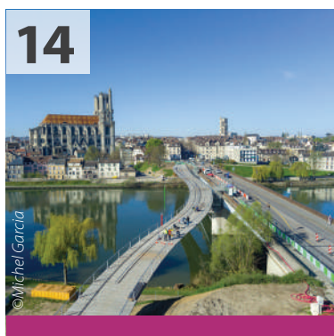
14 FOCUS SUR Inauguration de la Grande passerelle.
