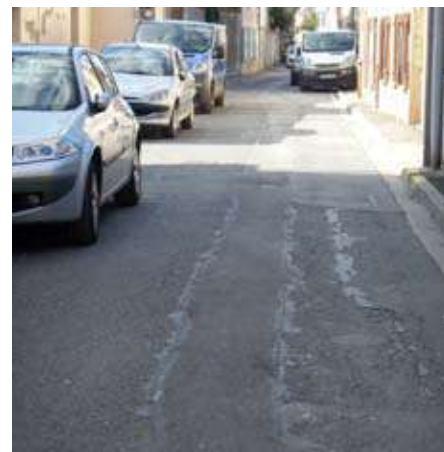
Rue Blaise Rigaud. En 2012, les rues B. Rigaud et du Maréchal Joffre feront l'objet d'une réfection totale comprenant l'enfouissement des réseaux.
