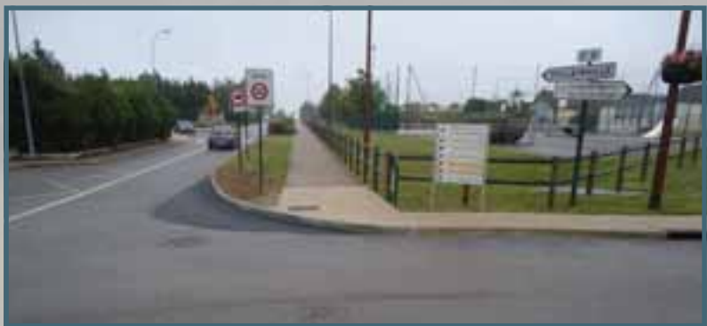
Réaménagement du giratoire avenue Édouard Fosse et Bd Aristide Briand
