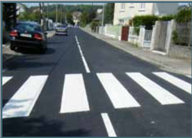
Réfection de la rue des Valléry
