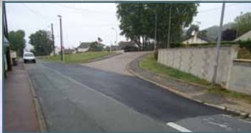
Réfection de voirie rue de la Résidence
