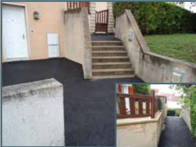
Réfection de l'allée située au-dessus du lavoir rue des Hauts de Limay
