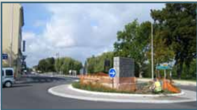
Aménagement d'un mur d'eau au centre du giratoire de la tête de pont
