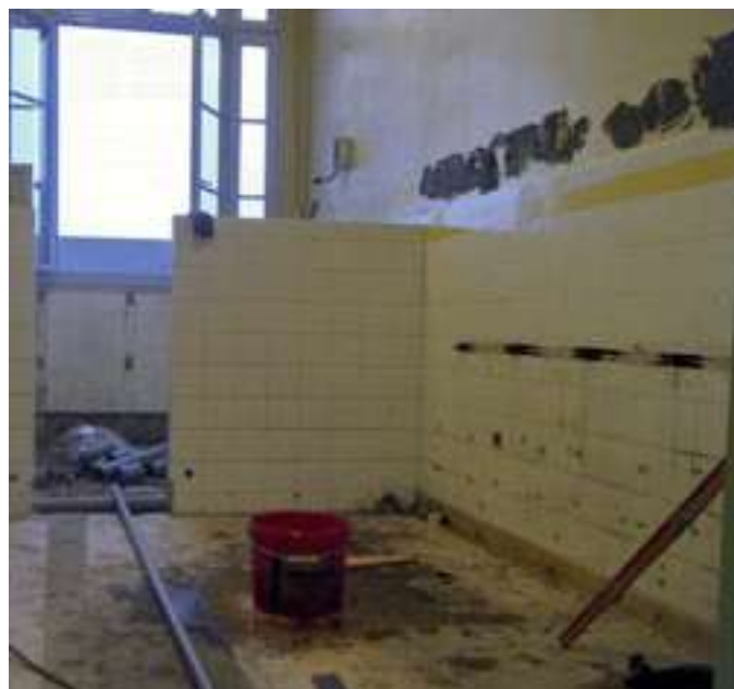
Réfection totale des sanitaires et changement des WC
