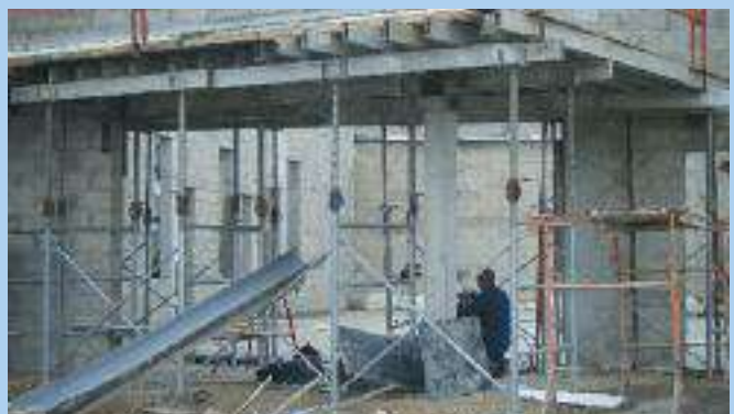
Extension du restaurant F. Buisson
