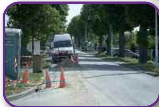
Poursuite des travaux d'assainissement avenue A. Langlois.
