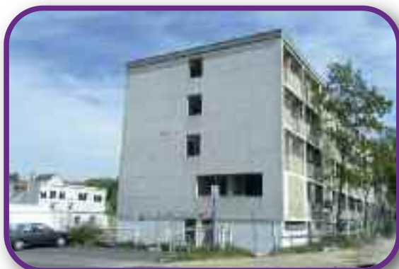
Gros travaux de réhabilitation du foyer AFTAM rue de la Chasse.
