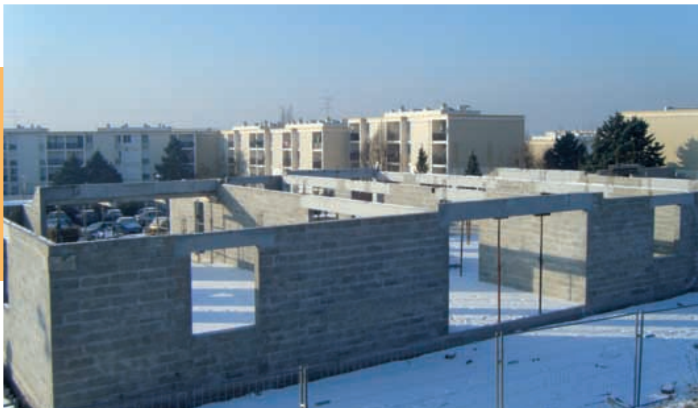
● Construction de la crèche rue des Hautes Meunières
